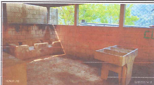
Foto 2: se quito la torta de cemento en la cocina y las estufa tambien
