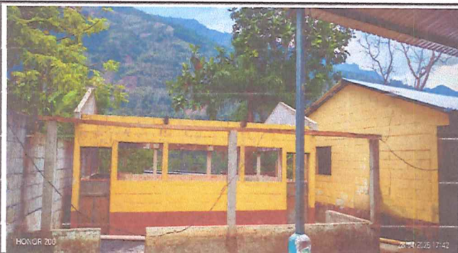
Foto 1: desmantelando la estructura de techo de la cocina
