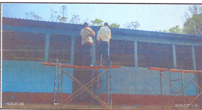
Foto 5: colocacion de los canales fluviales
