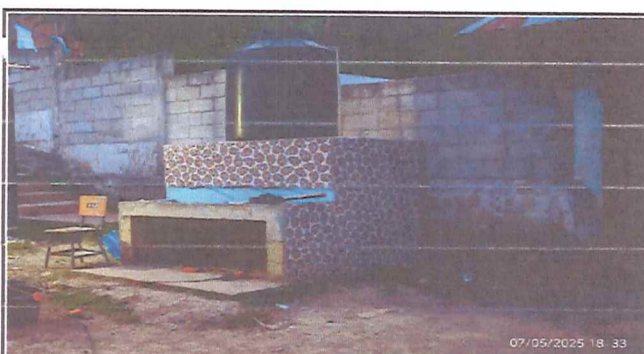
Foto 4: en proceso de reparacion de los lavamanos
